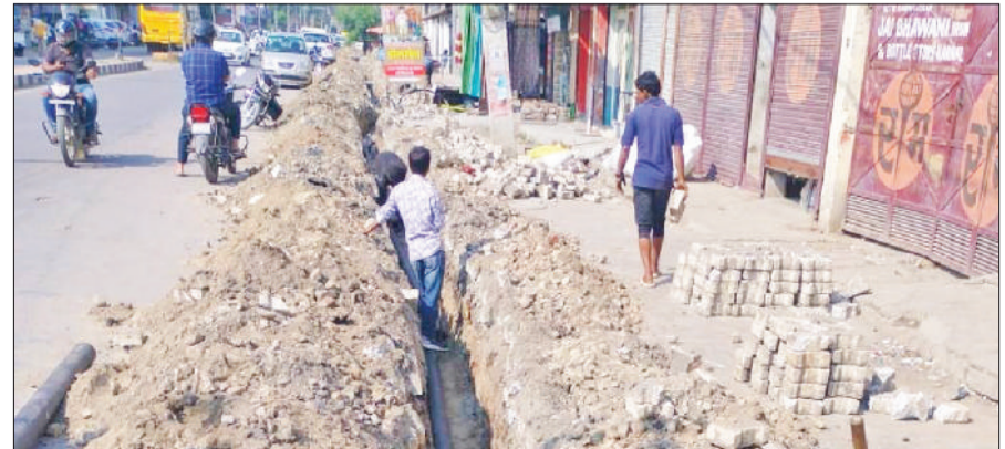
करनाल। जलापूर्ति सुधार के लिए बदली जा रही पाइप लाइन का कार्य।
